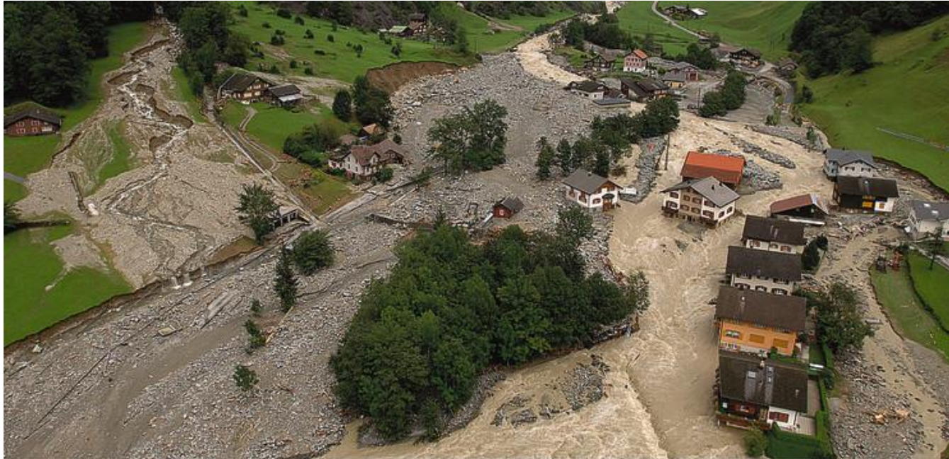
Kanton Uri, Tiefbauamt / Chärstelenbach im Reussgrund in Bristen UR, 2005
