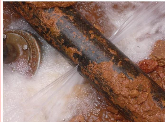
Bild: Leckage an einer Trinkwasserleitung
